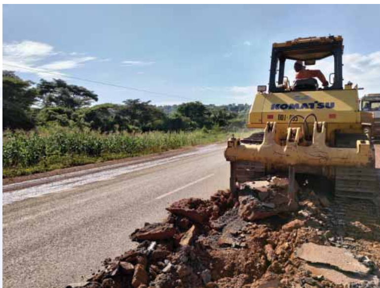
Скарификација њоспоеђе коловозне конспрукције
