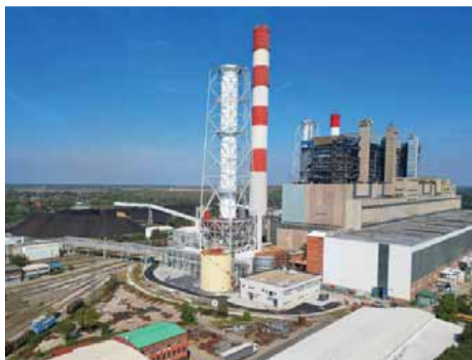
Термоелектрана „Никола Тесла“ са новим постојењем за одсумпоравање димних гасова
