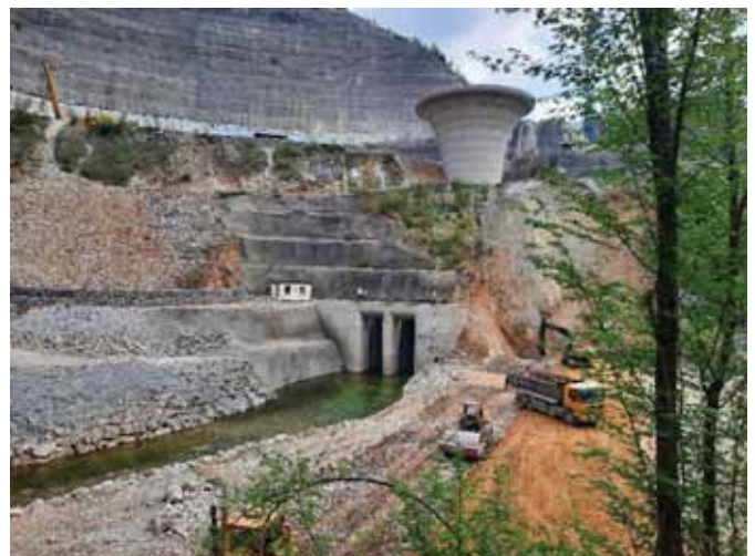
Улазна грађевина ойшочног шунела
