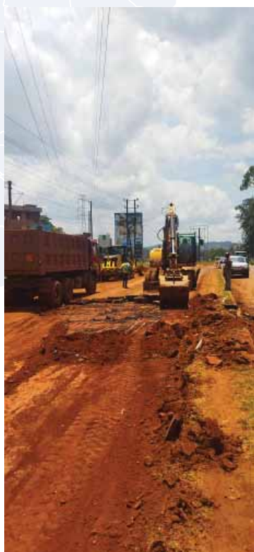
Уклањање постојеће коловозне конструкције
