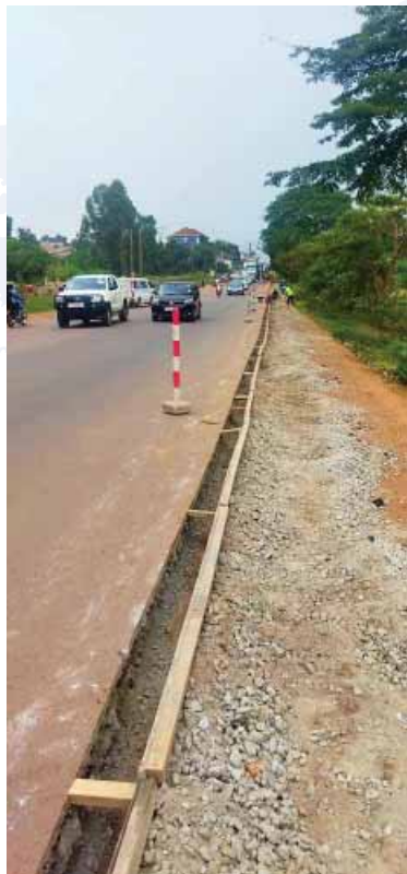
Израда бейтонске ивичне греде
