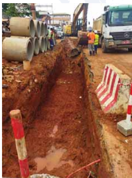
Ископ и постављање цеви за затворену дренажу
