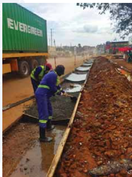
Бейонирање йлийких канала
