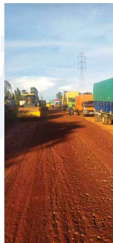
Израда слоја доње носеће слоја (subbase)
