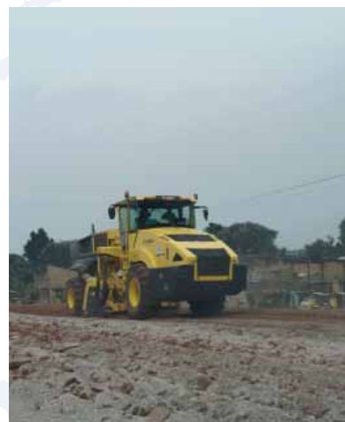
Израда доњеџ носеђеџ слоја (subbase)
