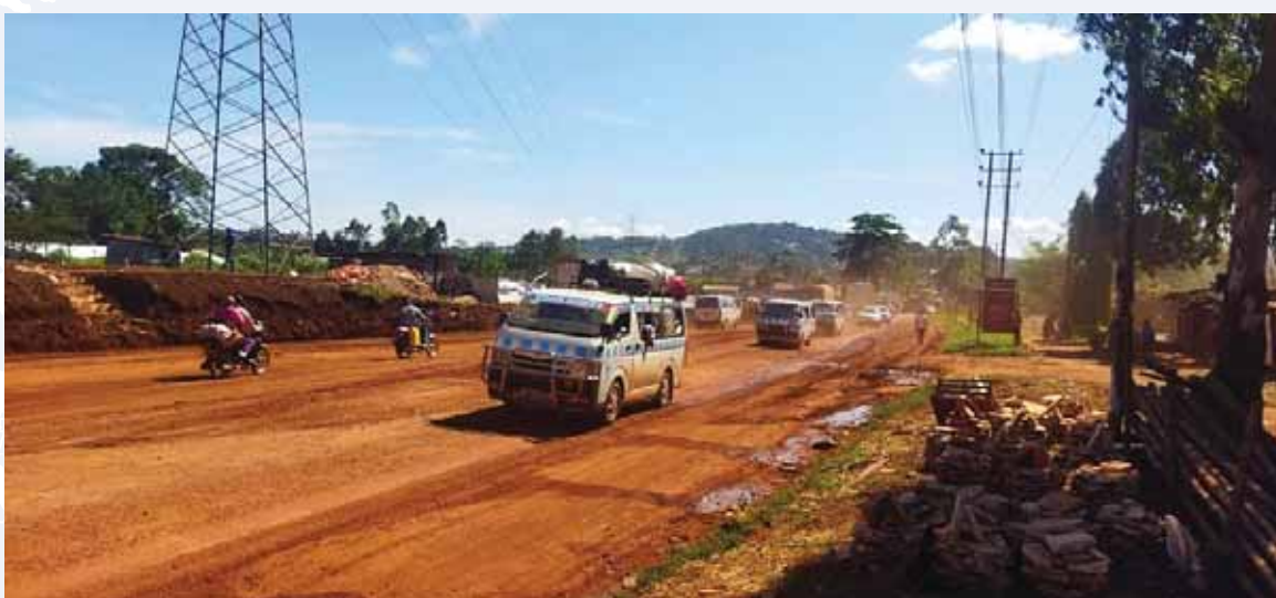
Израда доње носеће слоја (subbase), град Њеру
