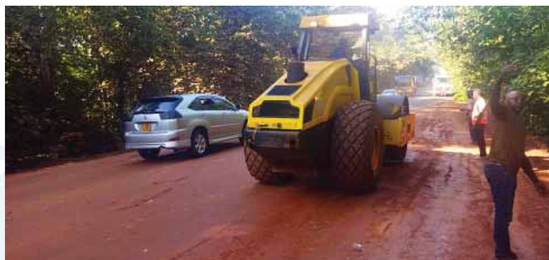
Одржавање постојеће пута, секција Мабира
