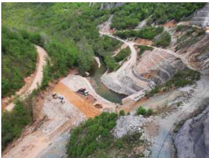
Узводни, насупи зајат којим је река В. Рзав скренуша у ойшочни шунел
