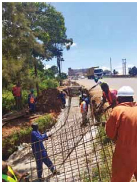
Израда бейтонских U канала
